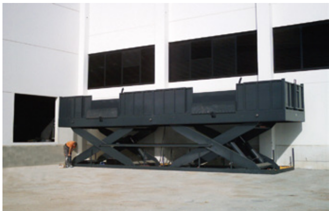
Mesa doble tijera horizontal para superar desniveles.
